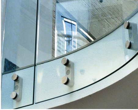
Ограждения на точках
